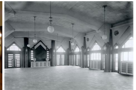
銀座クラシックホール・竣工当時
