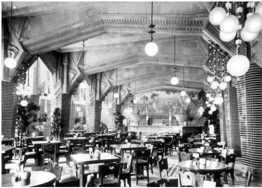
昭和9年竣工当時の様子
