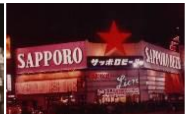
昭和 43 年取壊し前の様子
